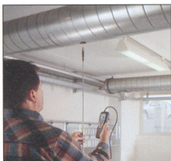
Injustering av tilluft i kök.
