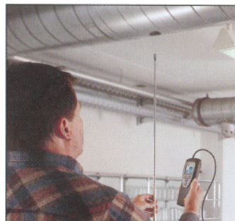
Injustering av tilluft i kök.
