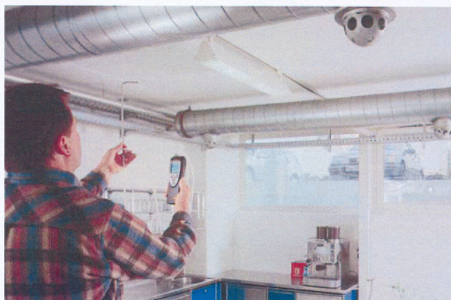
Injustering av tilluft i kök.
