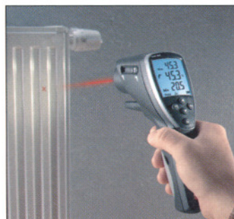
Temperaturmätning vid injusterings av värmesystem
