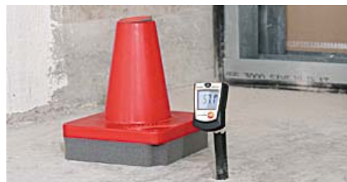
Mätning av luftfuktighet i betong
