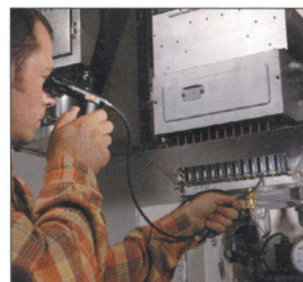
Visuella kontroller på svåråtkomliga platser
