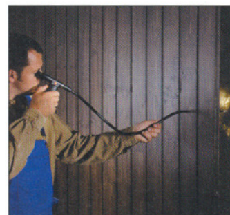
Kontroll av isolering med hjälp av det stabila decabon-skyddshöljet
